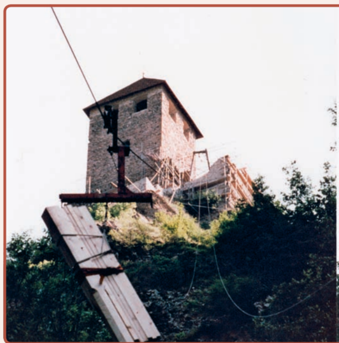
Eine vierstellige Zahl von Transporten besorgte während Jahren die Materialbahn über eine Höhendifferenz von 150 Metern. (Foto: BVG)
