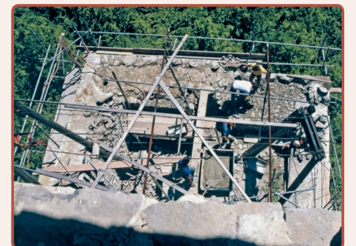
Blick vom Turm auf den Wohnteil südlich davon: «klein» und emsig wie Ameisen arbeiten unsere Aktiven am oberen Mauerabschluss. (Foto: BVG)
