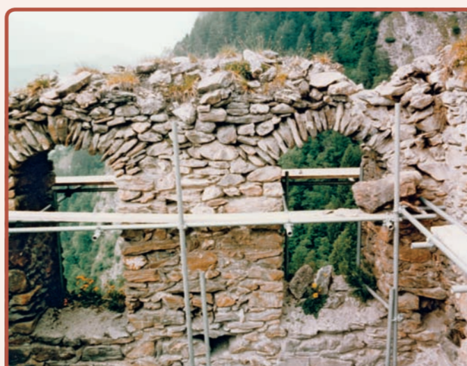
Die prekäre Situation im Bereich der nördlichen grossen Austrittsöffnungen auf eine Wehrlaube zu Beginn der Restaurierungsarbeiten. (Foto: BVG)
